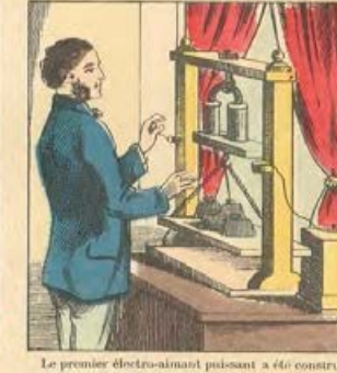
Le premier électro-aimant puissant a été construit en 1824 par Poullet. Il se composait d'un morceau de fer doux, courbé en fer à cheval, autour duquel circulait le courant. Dès que ce dernier cessait, l'aimantation cessait aussi, de sorte qu'on pouvait ainsi attirer et déseoirner le fer un nombre infini de fois dans une seconde.
